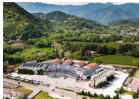
Standorte Sammelstelle, Vinifikations-, Schaum- und Abfüllanlage in Pieve di Soligo.
